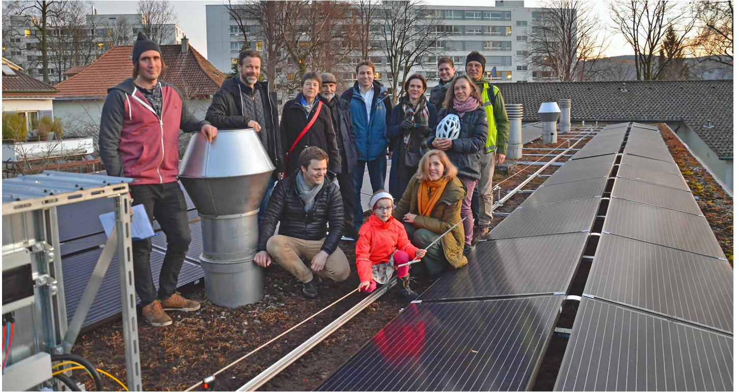
L'installation photovoltaïque Jolimont dans le quartier Ostring de Berne, réalisée en 2018 par Sunraising et des dizaines de propriétaires de panneaux solaires, a une puissance de 37 kWp et fournit du courant pour une soixantaine de ménages de la catégorie H4 par an.
