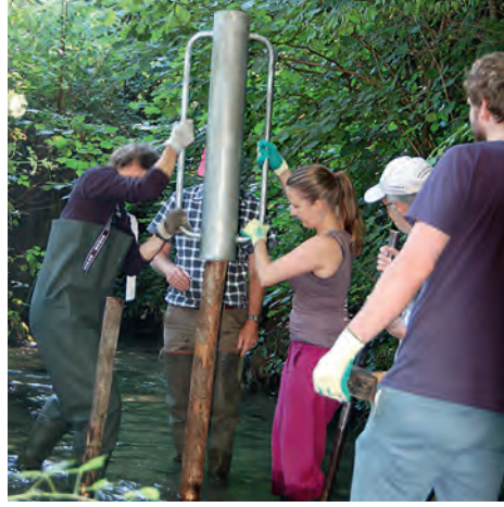
Um dem Bach mehr Strukturen zu geben, rammen die Freiwilligen mit Pfahlrammen Pfähle in den Bachgrund (links). Zwischen die Pfähle stecken sie dann Wurzelstöcke und grössere Äste.
