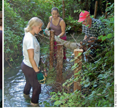
Um dem Bach mehr Strukturen zu geben, rammen die Freiwilligen mit Pfahlrammen Pfähle in den Bachgrund (links). Zwischen die Pfähle stecken sie dann Wurzelstöcke und grössere Äste.
