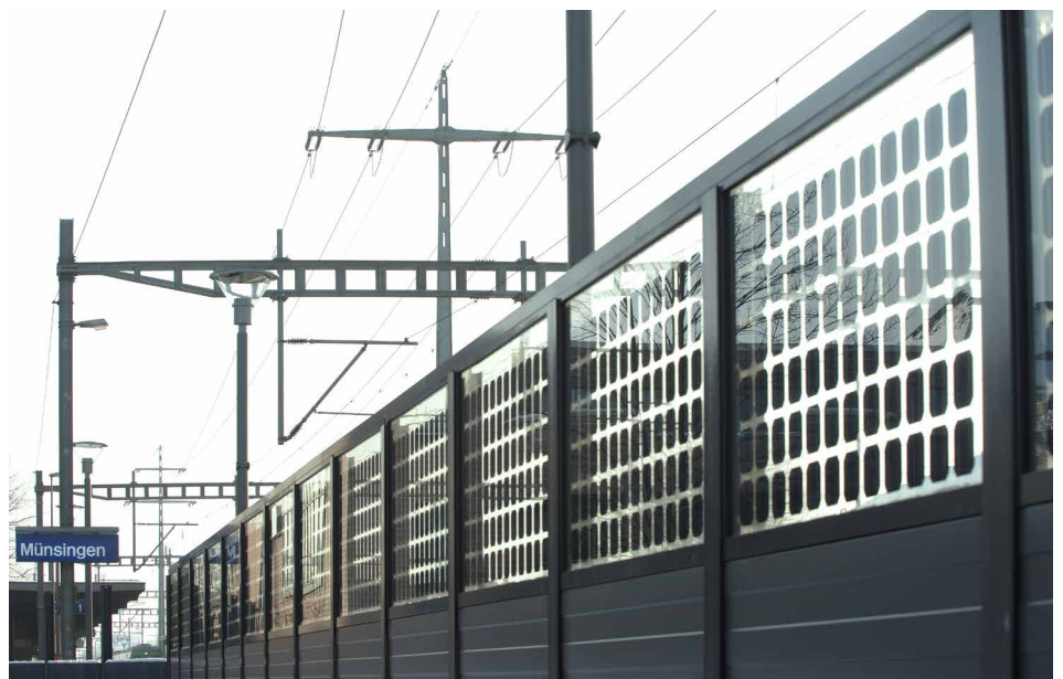
Energiepolitik heisst kreativ sein, wie das Beispiel der Lärmschutzwand in Münsingen zeigt, in die im oberen Teil Fotovoltaikzellen integriert sind.
