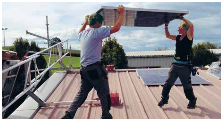
Montage der Solaranlage auf dem Dach der Möbelfabrik Bläuer in Biglen.
